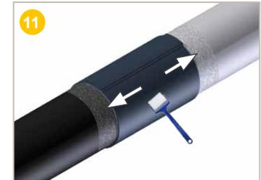
Quand la surface de la bande est encore chaude et malléable, utiliser le rouleau d'application pour **lisser** et **évacuer** les bulles d'air. Procéder de la même manière sur la fermeture.
